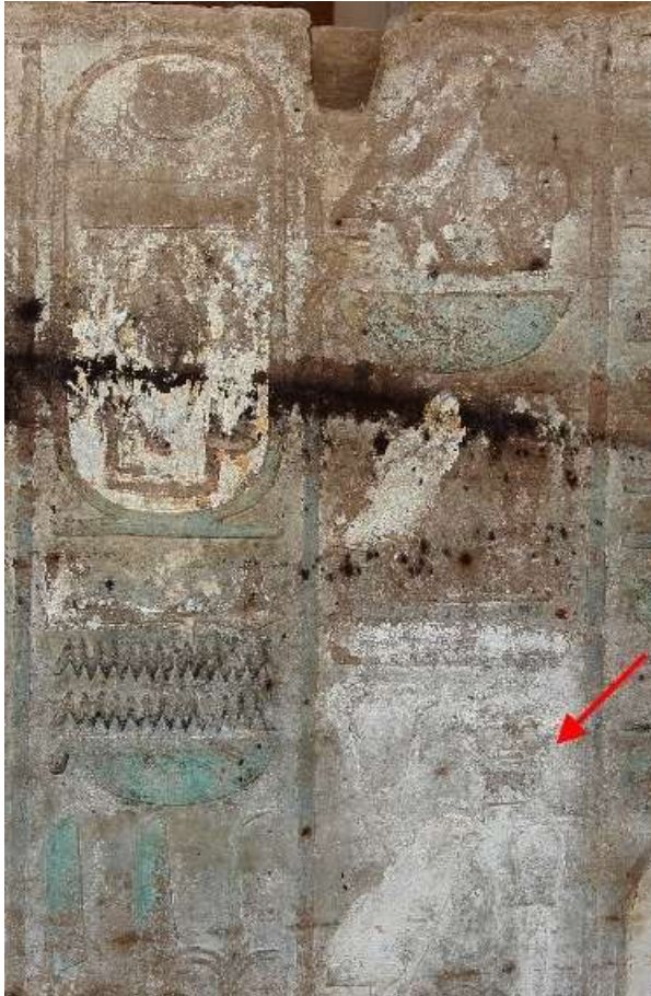
Fig. 22: Salt efflorescence (photo: E. Peintner, © DAI)
